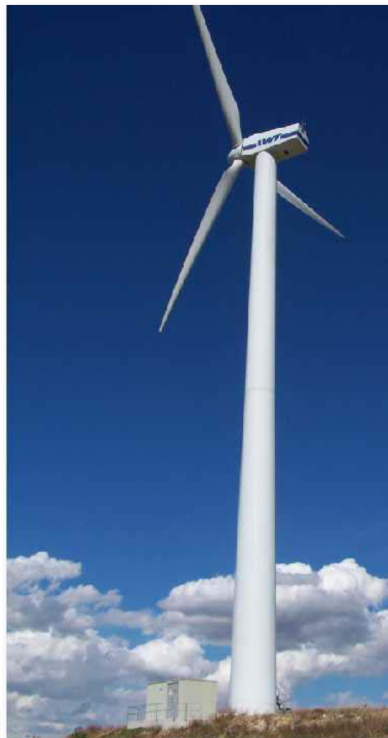
La centrale Eolica di Frigento (AV)
